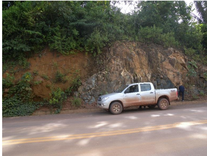
Foto 13 – Corte na BR-163 com variação lateral brusca de solo para rocha, na altura do km 766 do traçado da EF-170.
