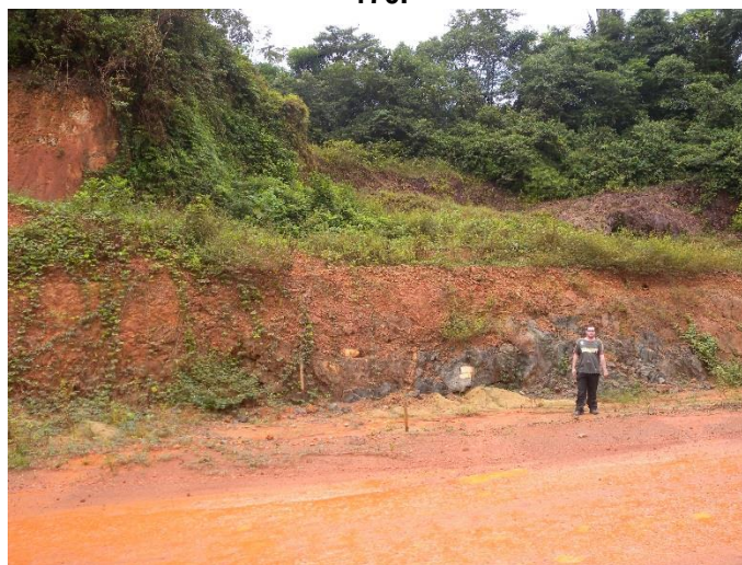
Foto 12 – Corte na BR-163 com variação horizontal e vertical de solo para rocha, na altura km 792 do traçado da EF-170.
