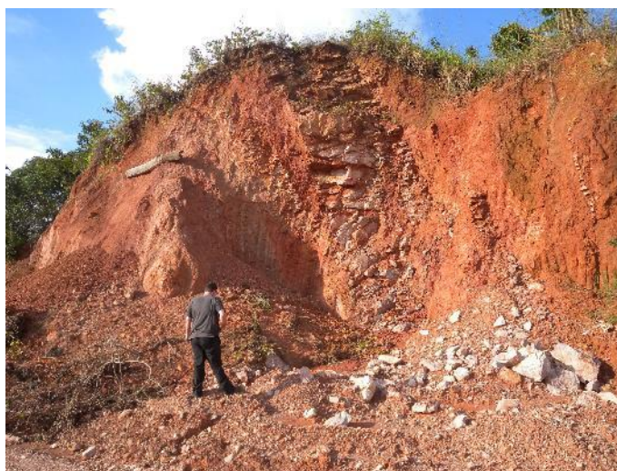
Foto 15 – Corte de estrada vicinal com intercalação de rocha e solo por volta do km 255 do traçado da EF-170.
