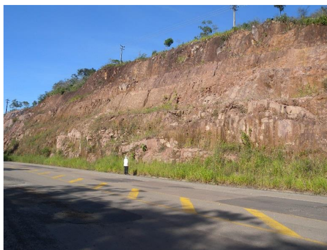
Foto 7 – Corte na BR-163, no km 235 do traçado da EF-170, na região de Garantã do Norte, em rochas de derrames félsicos da Província Tapajós. Notar intercalações de rocha com solo e presença de blocos mesmo no topo do corte, resultando em grandes variações no material escavado ao longo de todo o corte.
