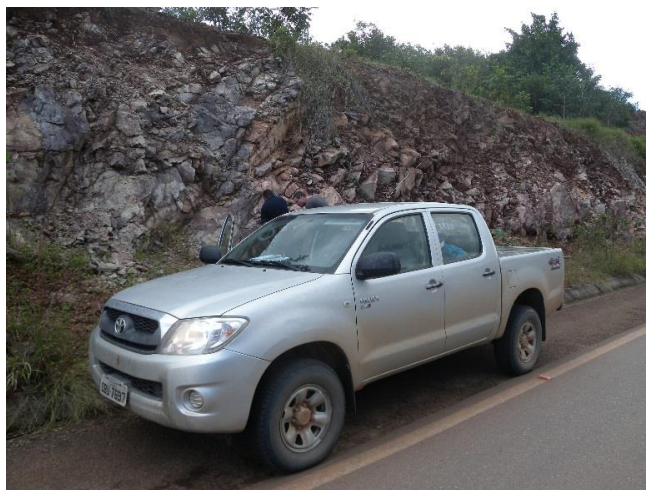
Foto 6 – Corte na BR-163, no km 269 do traçado da EF-170, próximo da região da Serra do Cachimbo, mas ainda no domínio das rochas de derrames félsicos da Província Tapajós. Notar que se trata de um corte de 4-5 m de altura inteiramente em rocha.
